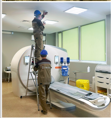
Рис. 2. Сверху – демонтированные устройства Honeywell. Снизу – монтаж "Стрельца-ПРО"
