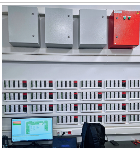
Рис. 3. Пожарный пост с приборами "Стрельца-ПРО" в Центре им. А.Н. Бакулева
