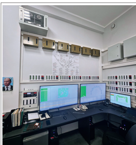
Рис. 3. Пожарный пост с приборами "Стрельца-ПРО" в Центре им. А.Н. Бакулева
